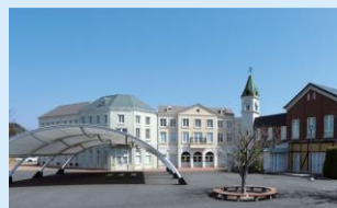
東京電力廃炉資料館
